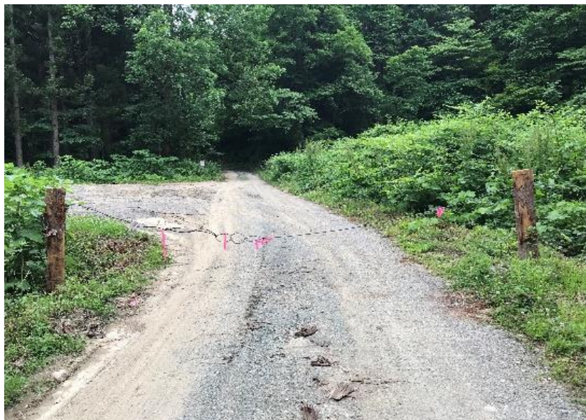
事業実行箇所につき、林道途中で施錠による交通規制あり（通行注意）
