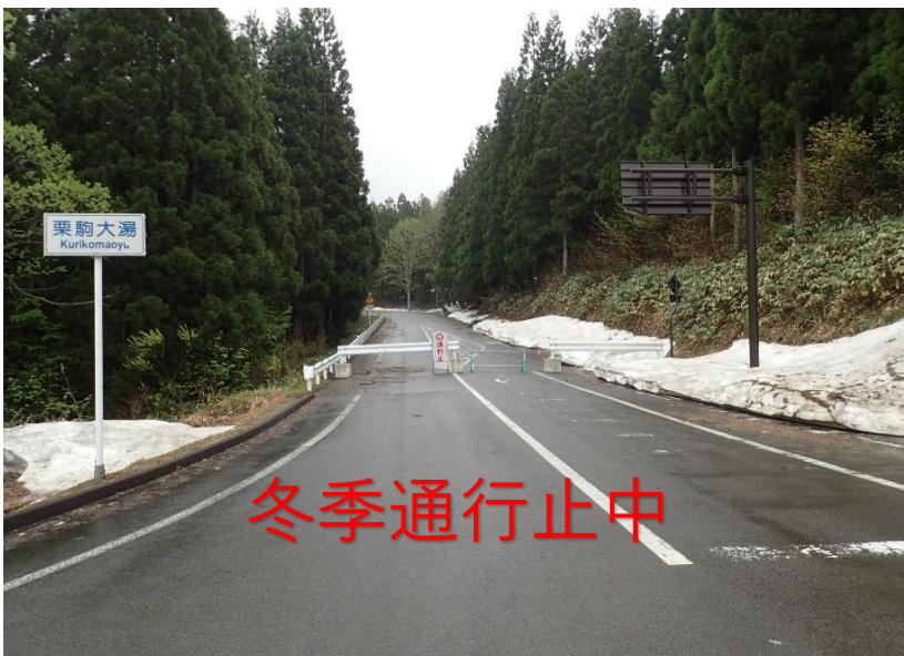
国道398号線（皆瀬方向）からは県道282号線がまだ冬季通行止です (5月下旬通行止解除予定)
