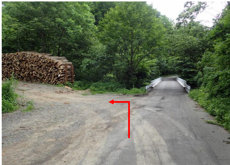
約300m先、乗上橋の手前左方向に山元土場入口
