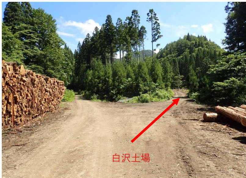
その先、林道分岐を右方向へ向かった先が白沢土場
