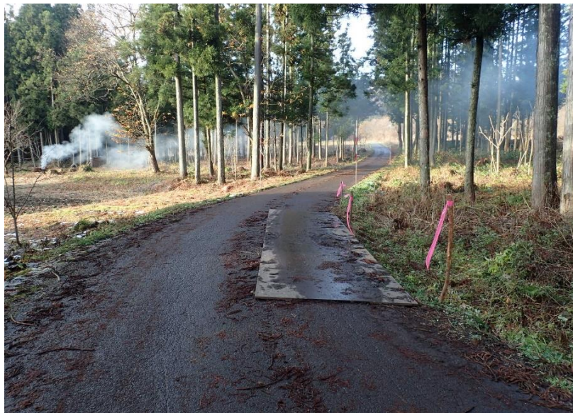
敷鉄板有り、また菅谷林道の舗装区間が約900m続きますが、 舗装路面保護のため「積載量に配慮したトラック運材」 をお願いいたします。
