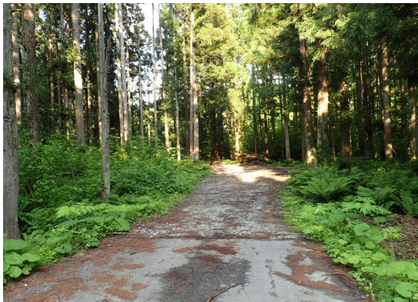
新瀬沢林道入口付近
