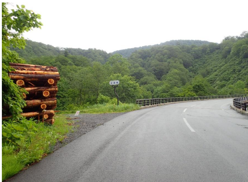
国道398号 大湯温泉から栗駒方面へ4.5 k m左側（紅葉橋手前）
