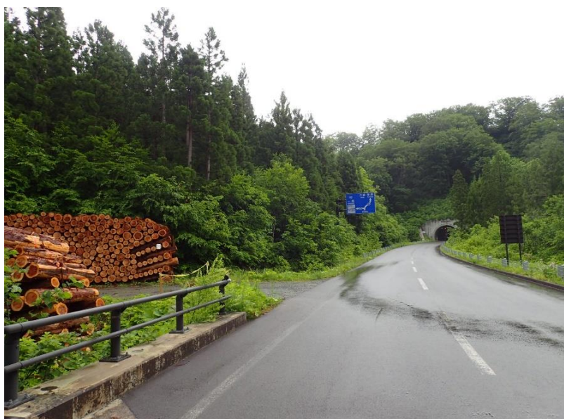
国道398号 大湯温泉から栗駒方面へ5.7 k m左側（槐橋を渡ってすぐ）
