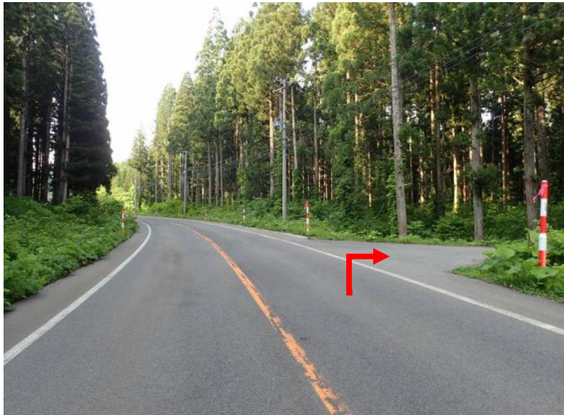
約450m先を右折して新瀬沢林道へ侵入 ※入口付近の巻立は本物件ではありません。
