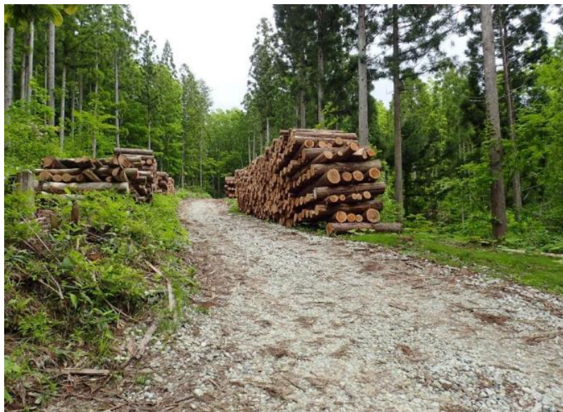
左折した先の向生保内土場状況
