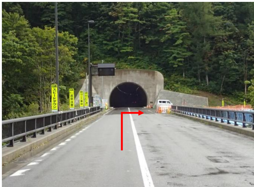
夢仙人大橋を渡りトンネルの手前を右折
